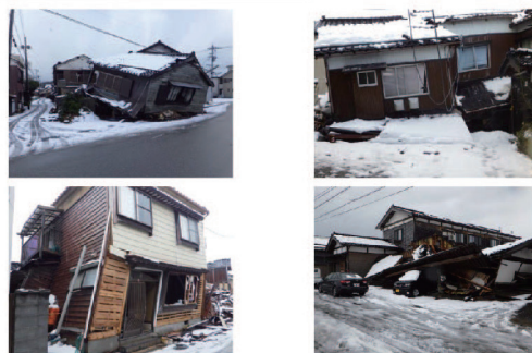
全壊した建物
