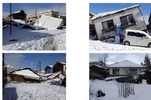
全壊した建物
