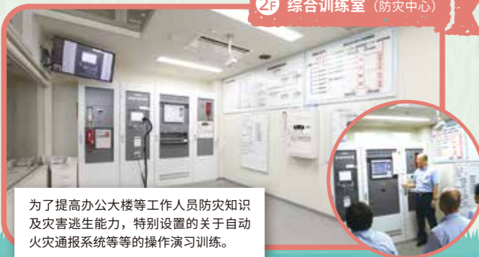
2F 综合训练室 (防灾中心)
